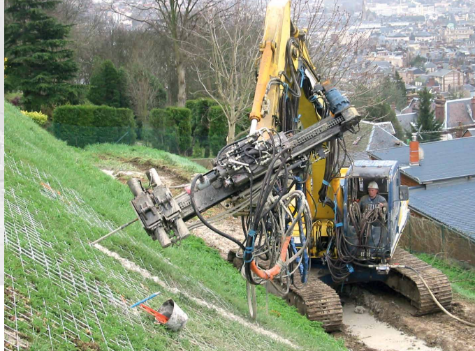
CONFORTEMENT DE TERRAINS
