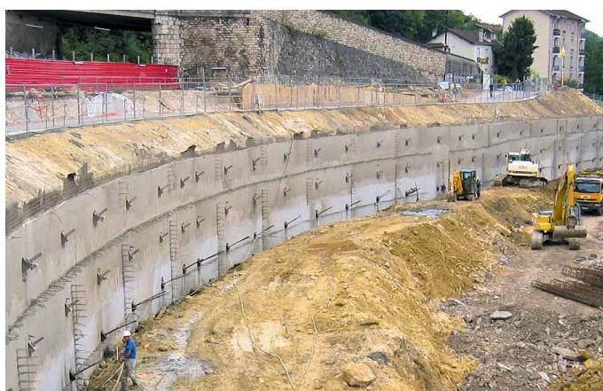
STABILISATION DE TALUS
