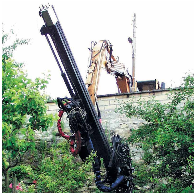
CONFORTEMENT D'OUVRAGES EXISTANTS
