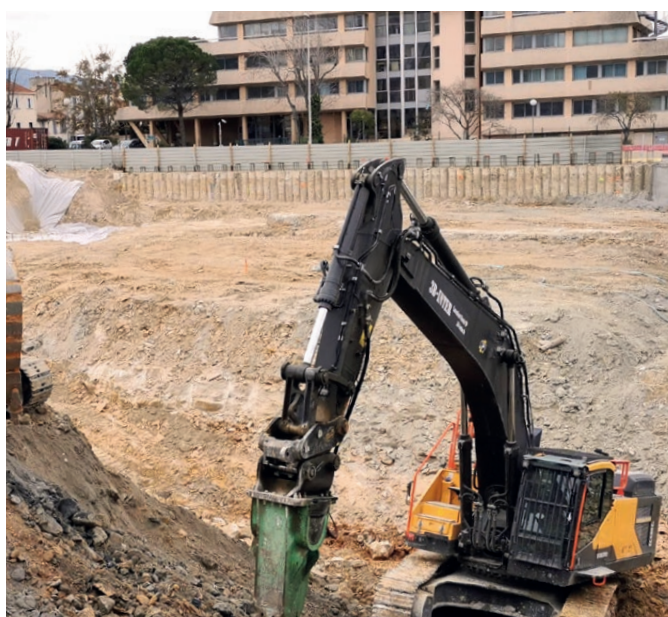
STABILISATION DE TALUS POUR TERRASSEMENTS
