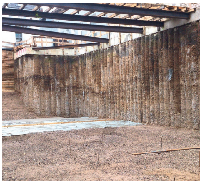
REPRISE EN SOUS-OEUVRE
