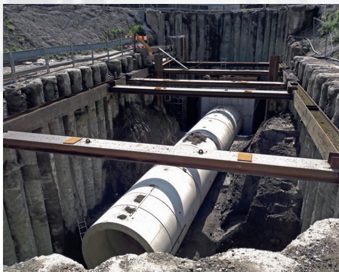
ASSAINISSEMENT (PUITS DE FONÇAGE, BASSINS DE STOCKAGE)
