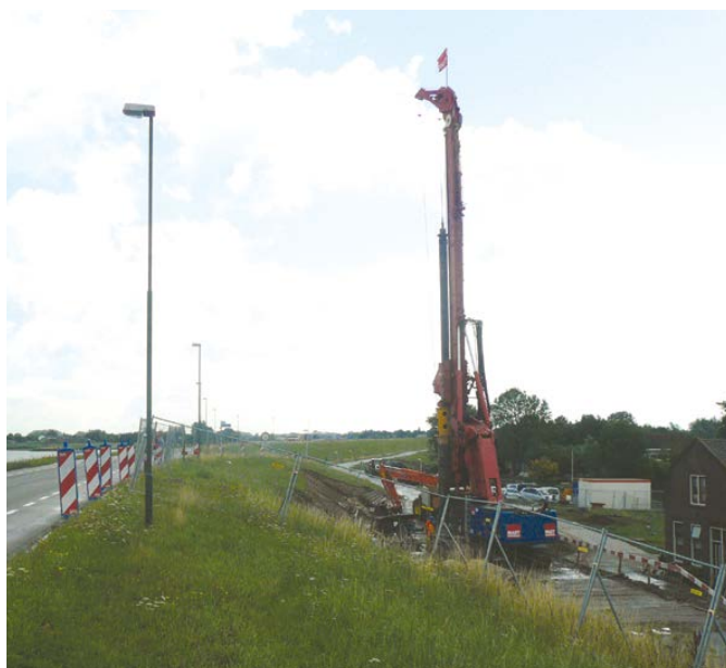
STABILISATION DE TALUS
