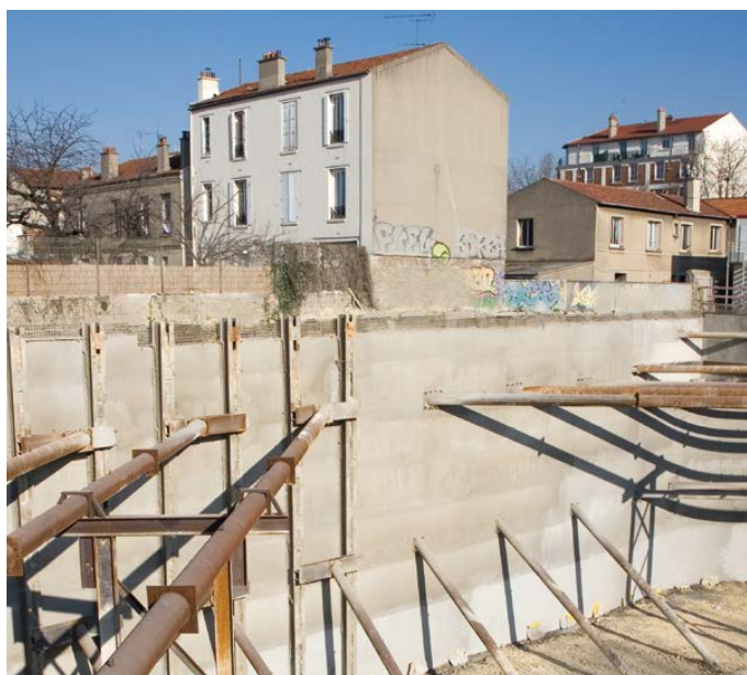
REPRISE EN SOUS-OEUVRE
