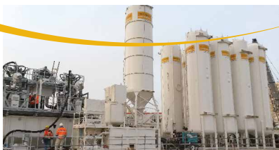
INSTALLATION DE CHANTIER
