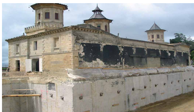
REPRISES EN SOUS-ŒUVRE
