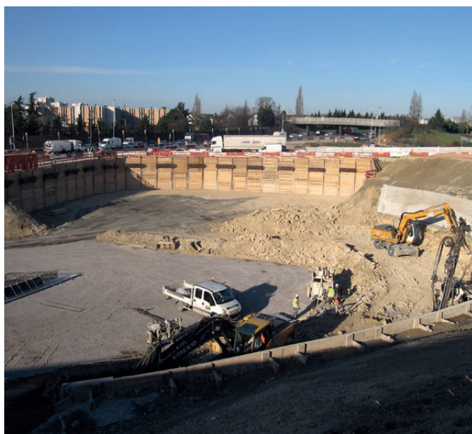
STABILISATION DE TALUS POUR TERRASSEMENTS
