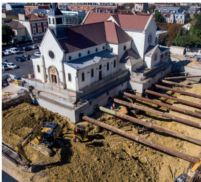
REPRISE EN SOUS-OEUVRE
