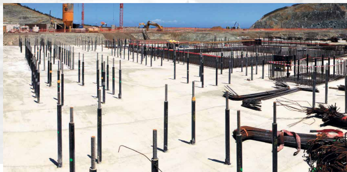
FONDACTIONS PROFONDES D'OUVRAGES
