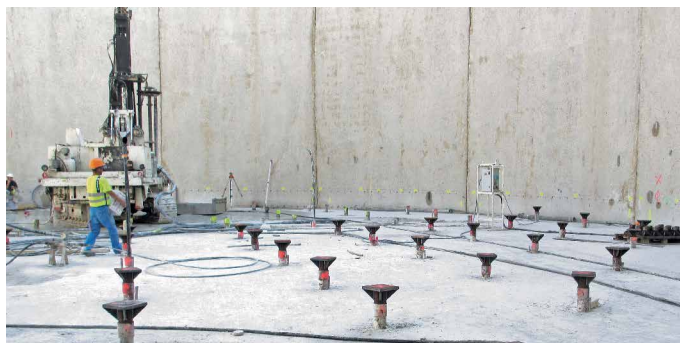
ANCRAGE DE RADIERS AUX SOUS-PRESSIONS
