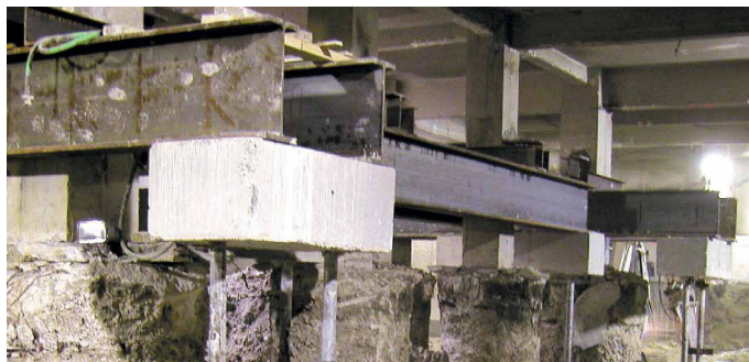
REPRISE EN SOUS-ŒUVRE D'OUVRAGES EXISTANTS
