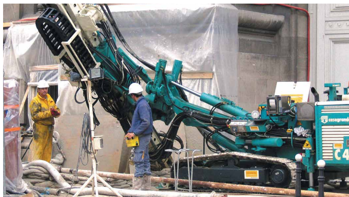
REPRISE EN SOUS-ŒUVRE D'OUVRAGES EXISTANTS
