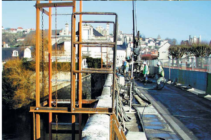
RÉGÉNÉRATION DE PILES DE PONTS
