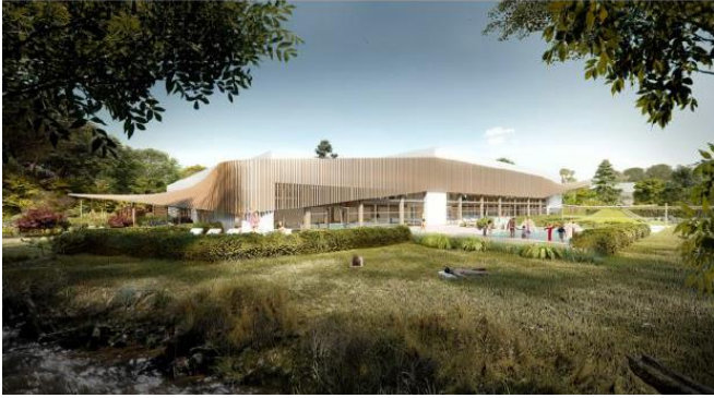
Crédit Photo : Cabinet d'architecture AP.MA
