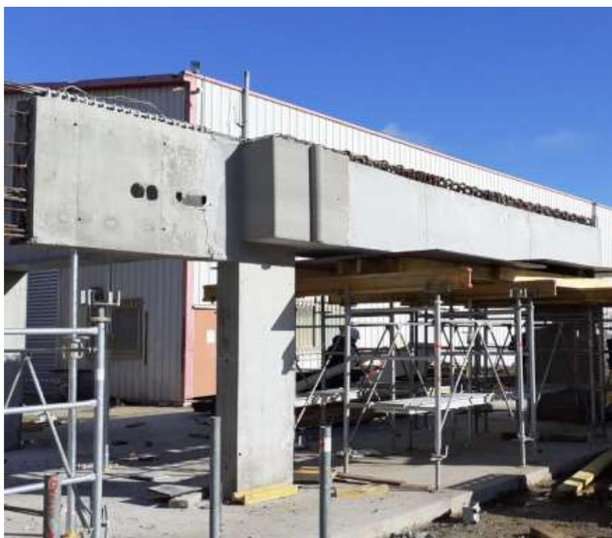
**2 - Les boîtes de réservations** font partie des coffrages les plus basiques généralisés sur un chantier. Traditionnellement réalisées en bois, elles servent à prévoir le passage des différents réseaux électriques, CVC et plomberie après coulage des voiles en béton. Bien qu'indispensables, leur mise en œuvre ne nécessite aucune expertise technique particulière mais occasionne un temps passé significatif.
