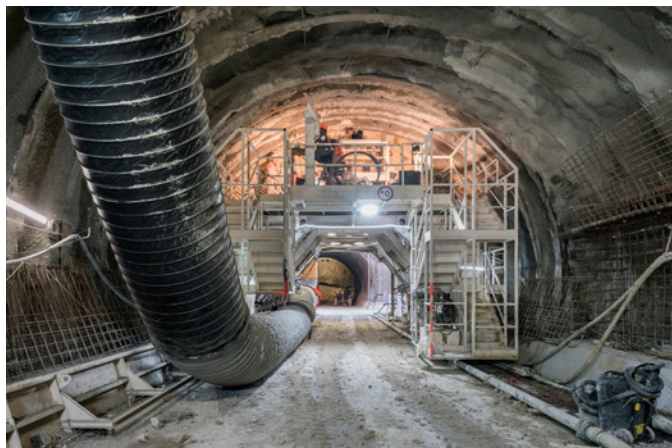
Tunnels en souterrain du prolongement de la ligne 4 du métro, de Montrouge à Bagneux - © Alex Soria
