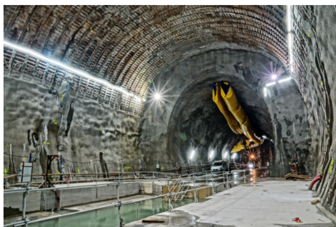
Lyon Turin Ferroviaire - Descenderie - © Vincent Photo
