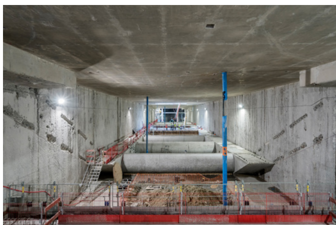
Ligne 14 Station Clichy-Saint-Ouen - © Alex SORIA
