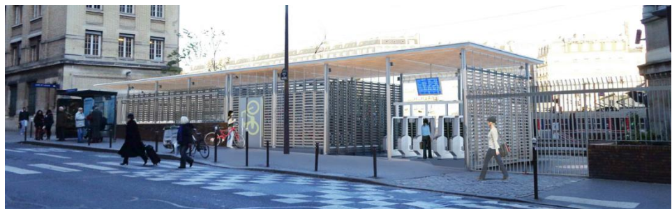
Portiques et abri pour vélos - Rue de Rome
