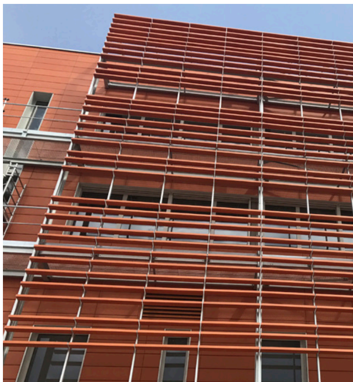
Bâtiment de R&D
